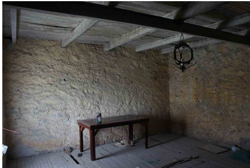
Figura 17. Estructura y entrepiso de madera.
