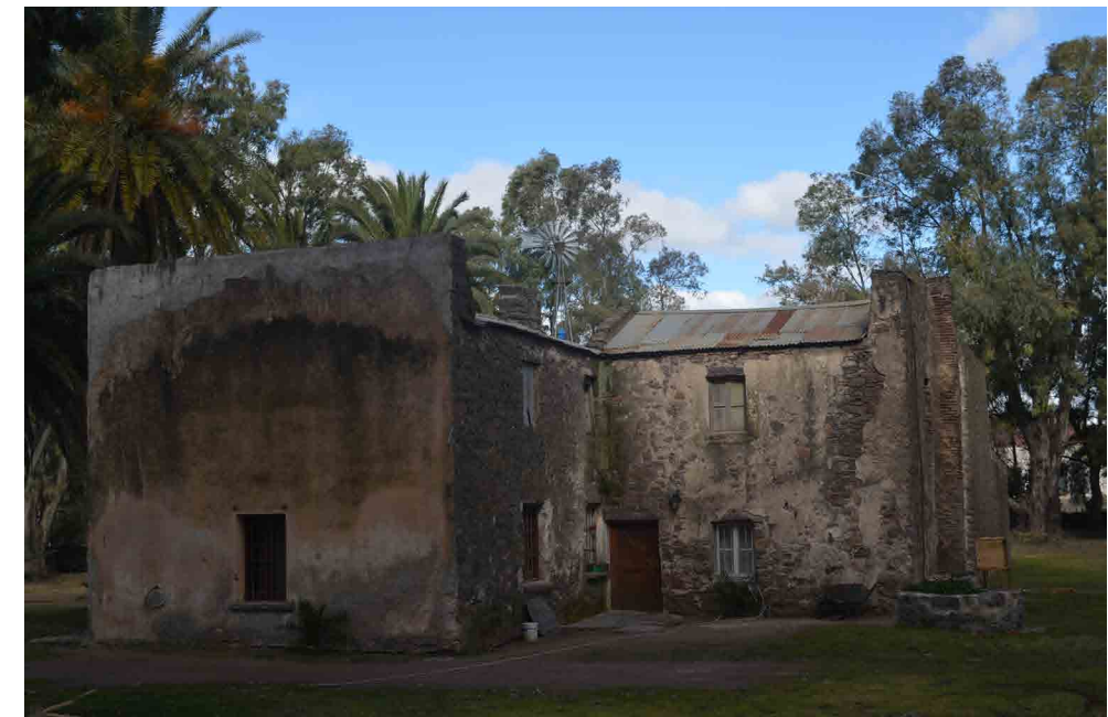
Figura 10. Vista lateral y acceso cocina.
