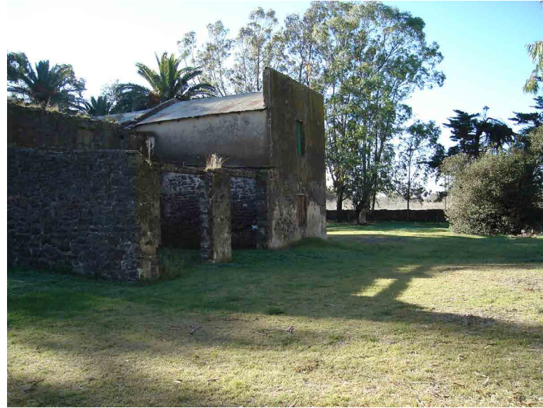
Figura 22. Sanitario y cochera adosados.
