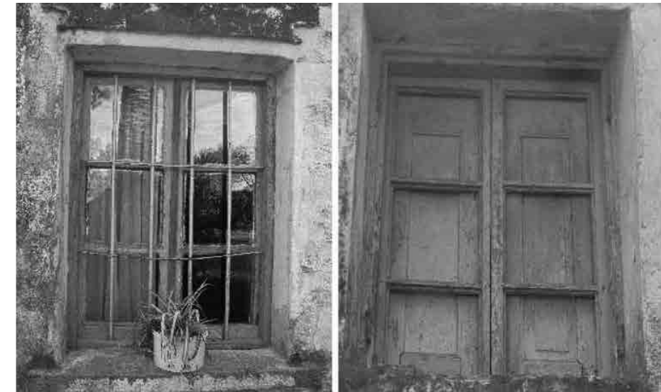
Figura 14. Ventanas de madera.
