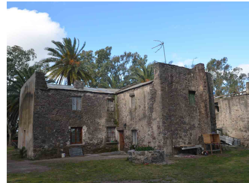
Figura 12. Cubierta a dos aguas.
