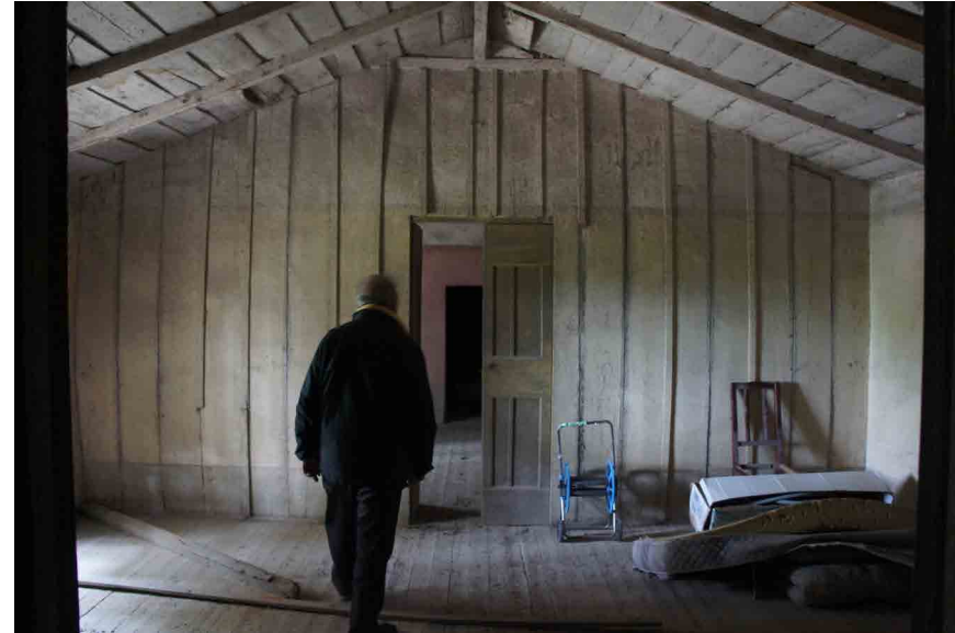
Figura 16. Paneles divisorios en planta alta.
