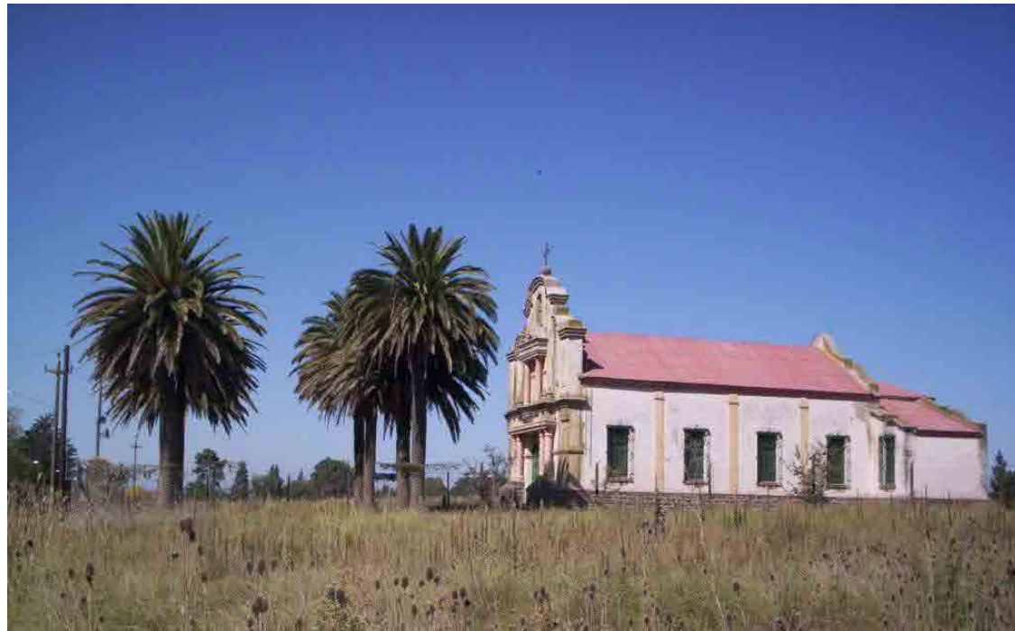
Figura 31. Vista lateral de la Capilla Santa Lucía.
